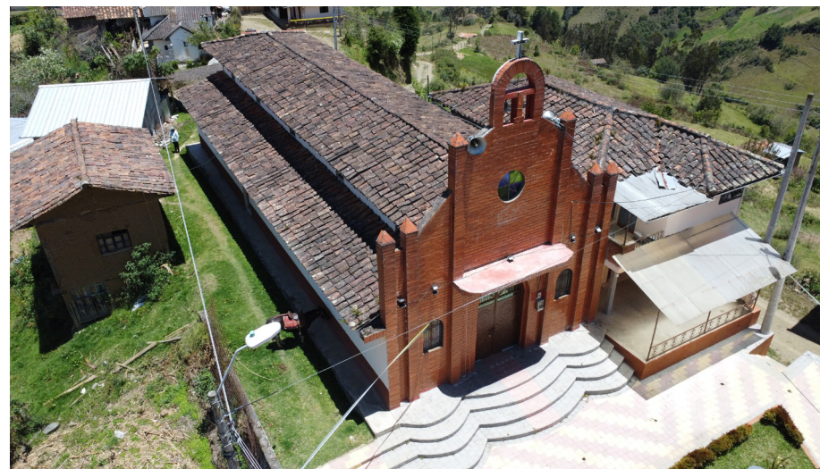
Fotografía N° 10 Capilla – Comunidad de Manzanapata. Fuente: Equipo Consultor, 2024
