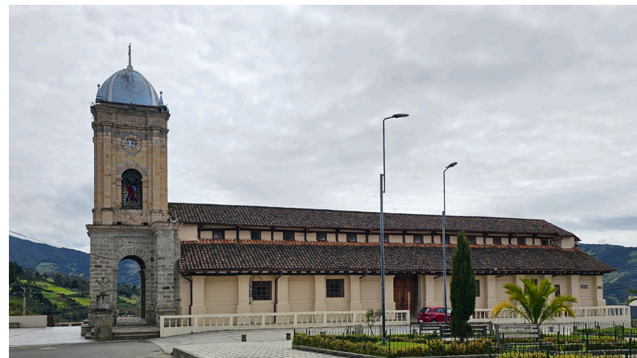
Fotografía N° 3. Bien patrimonial - IBI-03-01-60-000-000001 Fuente: Equipo Consultor, 2024
