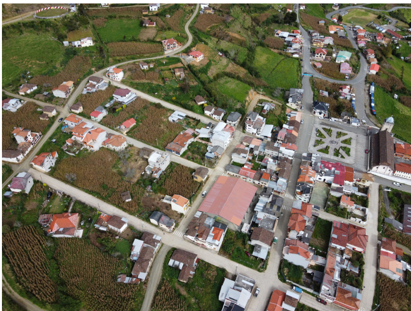
Fotografía N° 11. Estado de la capa de rodadura – Centro Parroquial. Fuente: Equipo Consultor, 2024
